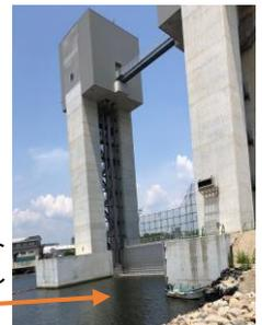
閉鎖の最終工程まで通常操作で約25分、緊急操作で約10分。この新川水門と一連の防潮堤の整備により堤内地の浸水範囲が約9割縮減されるということです。
