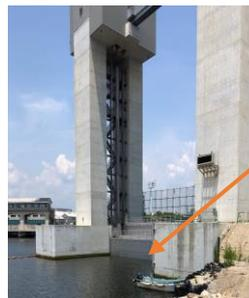
背面のゲートは水上面で停止し、手前のゲートは海底まで下がる
